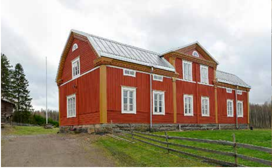
Pohjalaismallisen talon seinät kaatuvat ylös mentäessä hie- man ulospäin, jolloin räystäitä ei tarvita eikä kivijalka kastu.
