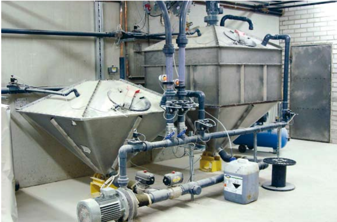
Suurempi säiliö on varsinainen sekoitussäiliö, pienempi toimii apusäiliönä, joka mm. syöttää putkistoon rehupatsasta työntävän veden.
