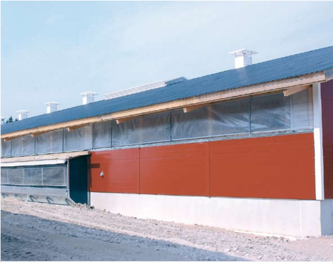
Painovoimaista savunpoistoa varten tuotantorakennuksessa on oltava joko erillinen savunpoistoaukko luukkuineen (tässä rakennuksessa katossa keskellä), tai huonetilan yläosissa helposti rikottavia ikkunoita tai luukkuja sekä korkeita oviaukkoja. Myös poistoilmahormit toimivat savunpoistoaukkoina.
