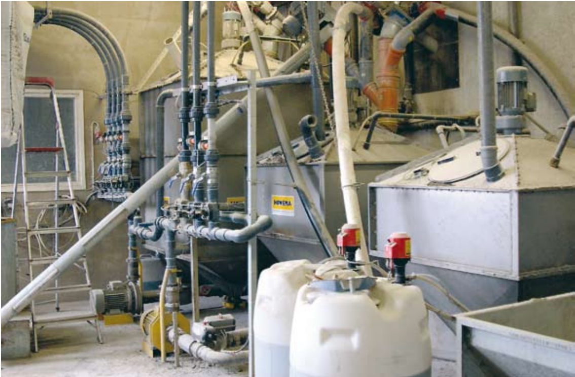
Rehukeskuksessa on kaksi sekoittavaa liemiruokkijaa. Suurempi palvelee joutilas- ja tiineytysosastoja, pienempi apusä- liöineen vieroitus- ja porsitusosastoja.
