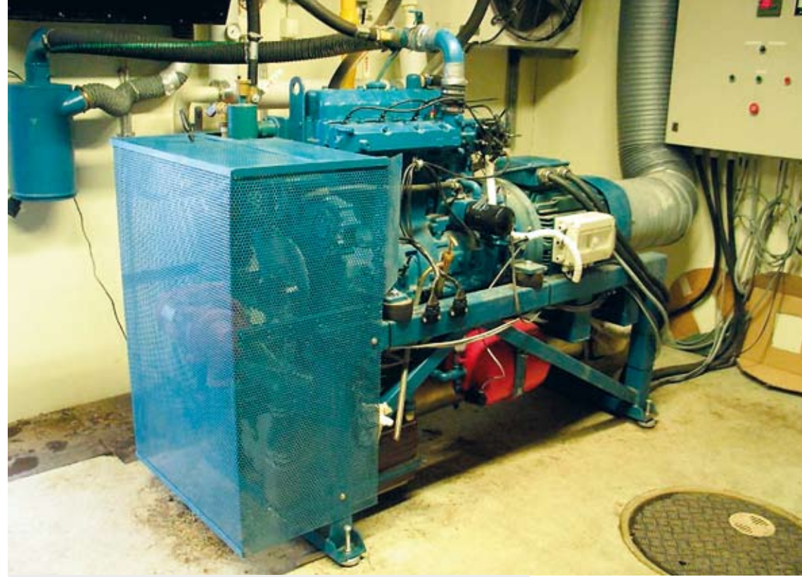
Kaasun talteenotto vähentää ympäristöhaittoja sekä parantaa lietelannan levitysominaisuuksia ja mahdollisesti myös lannoitusvaikutuksia. Tavallisesti kaasulla tuotetaan maatilan tarvitsema lämpö ja iso osa myös sähköä. Kuvassa oleva Metenerin kaksinopeusaggregaatti 22/30 kW pohjautuu Sisu-dieseliin.
