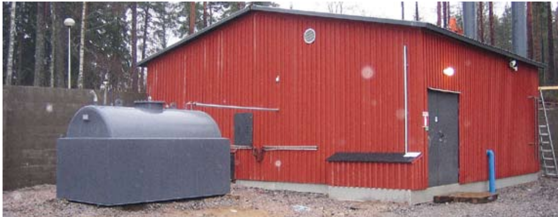
↑ TTS:n Lönnrot opisto Sammatissa liitettiin hakelämpöön lokakuussa 2009. TTS:n omistamalla 700 kilowatin hakelämpölaitoksella tullaan lämmittämään myös alueelle nousevaa kolmenkymmenen asunnon elinkaariasumisen koerakentamisaluetta. Lämpölaitoksen hoidosta vastaa Osuuskunta Nummen perusenergia. Kuva: Urpo Nurmisto
