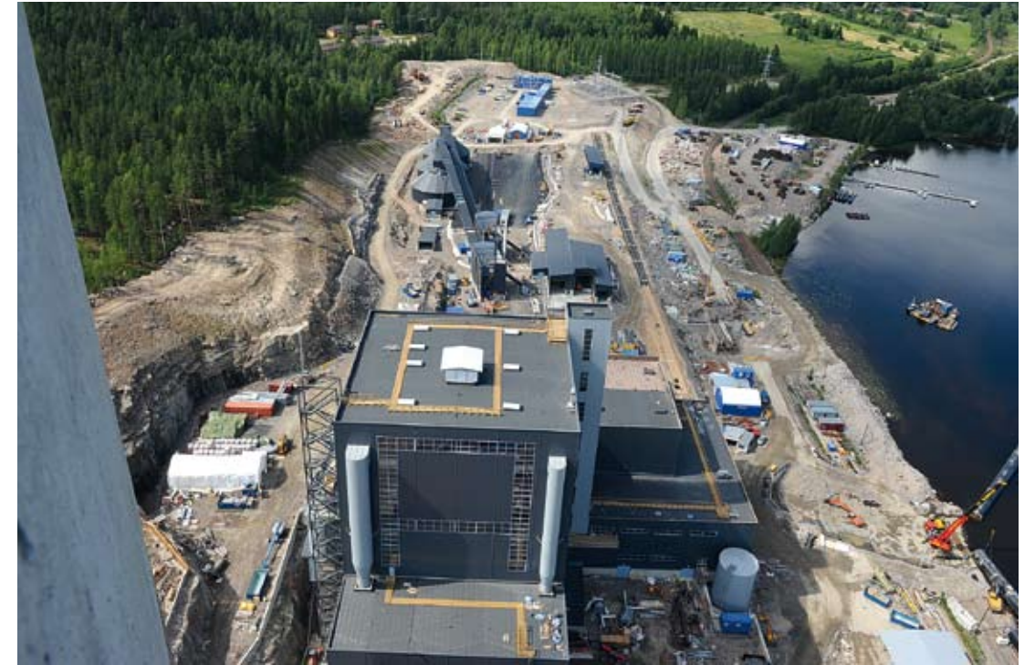
↑ Keljonlahden voimalaitoksen rakentaminen oli mittava urakka: 700 henkilön huippumiehityksen aikana Keljonlahti oli heti Olkiluodon jälkeen Suomen toiseksi suurin rakennushanke. Keljonlahdella suomalainen työvoima oli enemmistönä. Kuva: Suveko Oy/Kalevi Korhonen
