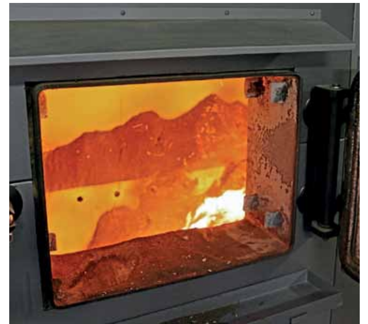
➔ Arimax-kattilassa on liikkuva arina, pakokaasujen osittainen takaisinkierrätys ja palokaasujen partikkelit erotetaan pohjaosan avoimeen vesipatjaan. Vasemmalla näkyvää varakattilaa ei ole juuri tarvittu. Lisäksi öljy alkaa olla niin kallista, että sitä ei haluta käyttää edes huippukuormitusten aikana. Liikkuva arina toimii hyvin haketus-tuoreen (kosteus 30–35 %) tavaran poltossa.
