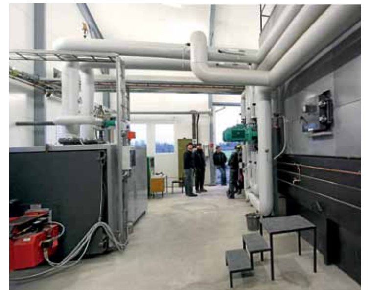
➔ Arimax-kattilassa on liikkuva arina, pakokaasujen osittainen takaisinkierrätys ja palokaasujen partikkelit erotetaan pohjaosan avoimeen vesipatjaan. Vasemmalla näkyvää varakattilaa ei ole juuri tarvittu. Lisäksi öljy alkaa olla niin kallista, että sitä ei haluta käyttää edes huippukuormitusten aikana. Liikkuva arina toimii hyvin haketus-tuoreen (kosteus 30–35 %) tavaran poltossa.
