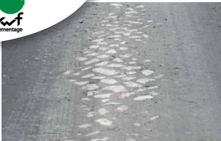
↑ ↑ Erialaisten telatyyppien vertailussa pohjoismaiset kokoterästelat ovat kantavuudeltaan omaa luokkaansa. Niiden käyttöä Saksassa rajoittaa teiden vaurioituminen, sillä metsätiet ovat kivettyjä tai jopa asfaltoituja.
