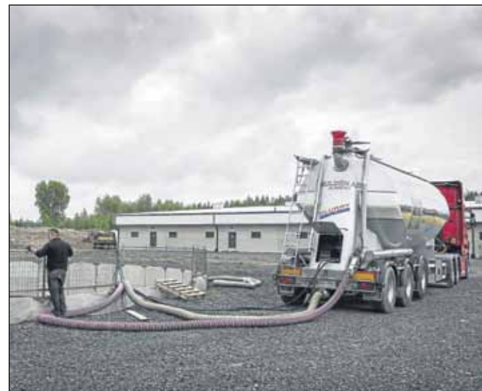
Siirtovaunut täytetään uppopumpulla, jota pyöritetään vaunuihin asennetuilla hydraulikkajärjestelmillä.
