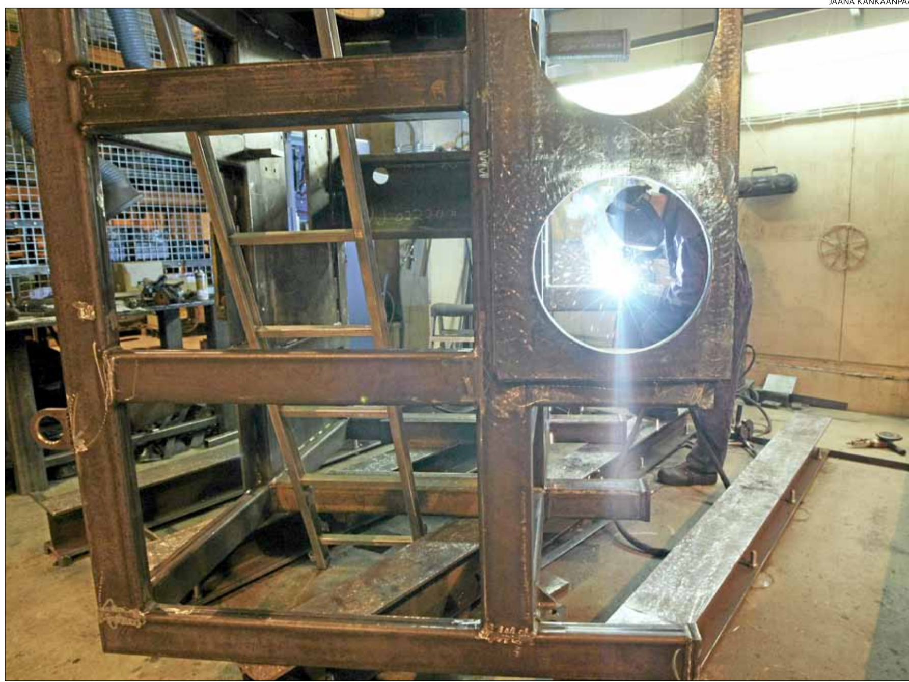
Ville Pöyry hitsaa sahakonetta Mäntyharjulla Veiston tehtaalla.
