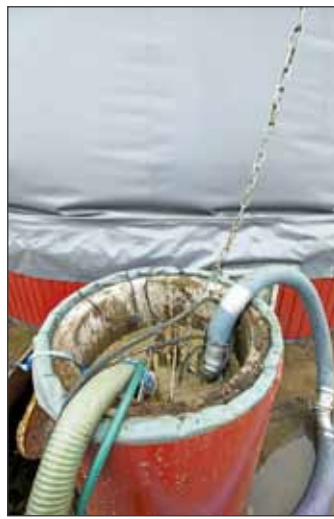
Pumppu nostaa lietteen. Ruuvi työntää kuiva-aineen kuljettimelle, joka siirtää sen eteenpäin.
