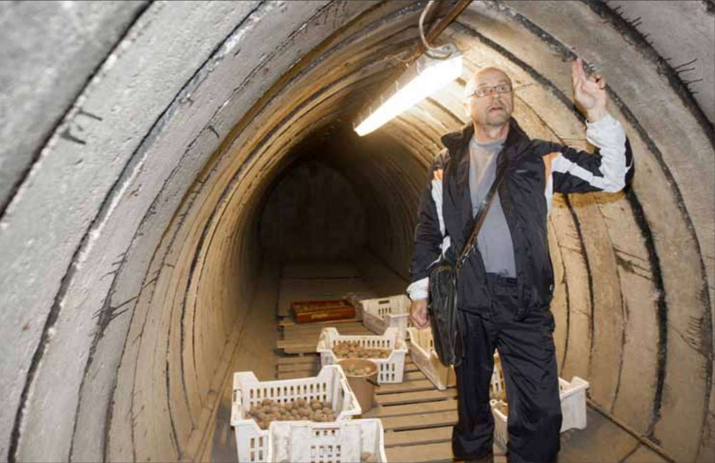
Orkolassa sijaitsevat Salpalinjan ainoat elementeistä rakennetut lamellikorsut, kertoo Risto Häkämies. Tätä korsua maan-omistaja on käyttänyt perunakellarina.
