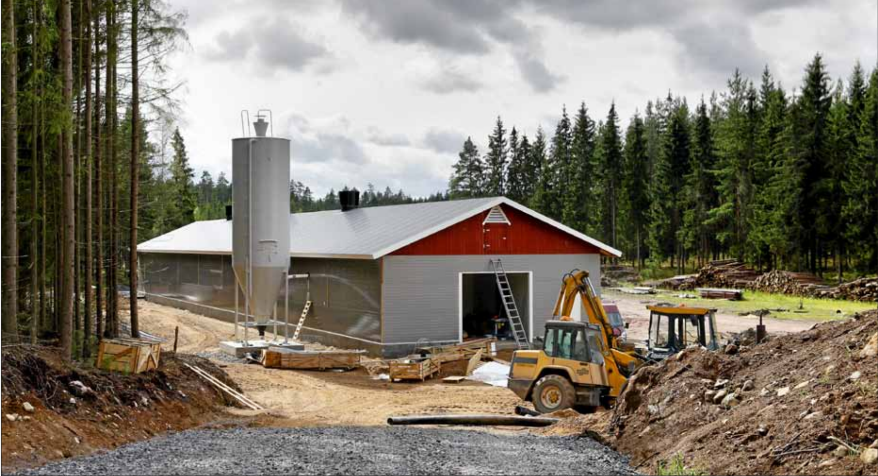
Isotalon uudessa kasvatuskanalassa on ristikkorakenteinen peltikatto.
