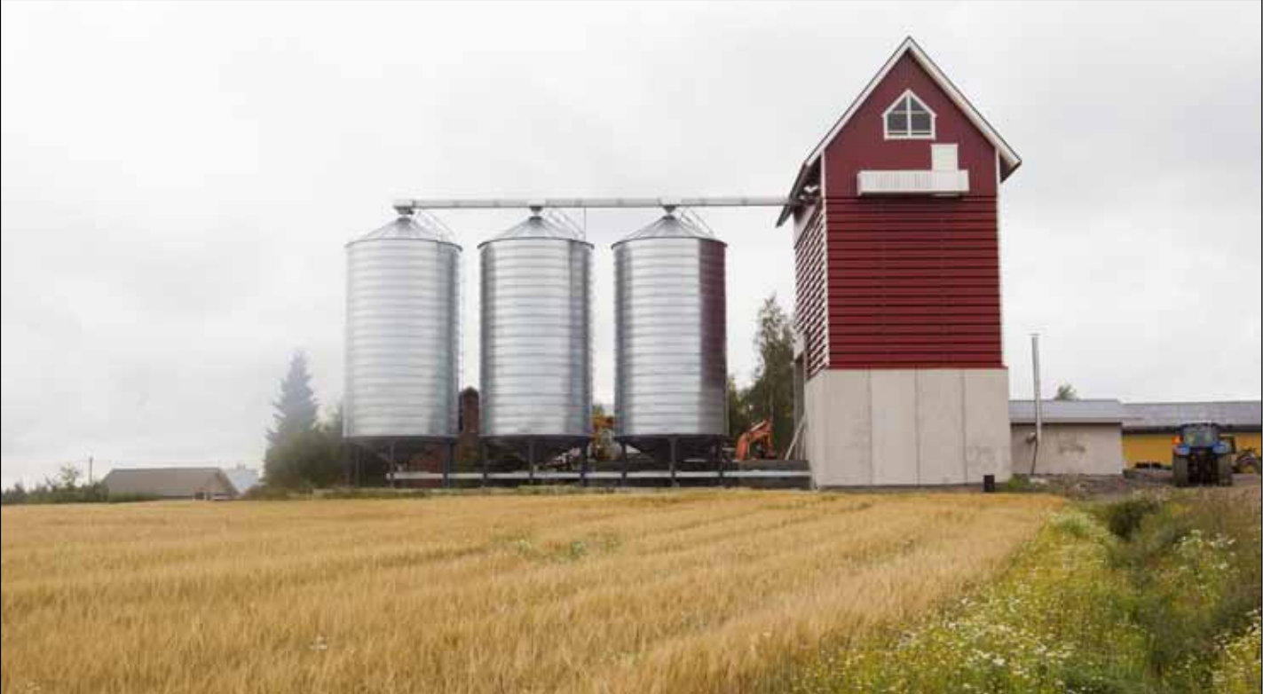
Yli-Antolan uuden kuivurin kylkeen rakennettiin vielä kolme 240 kuution varastosiiiloa.
