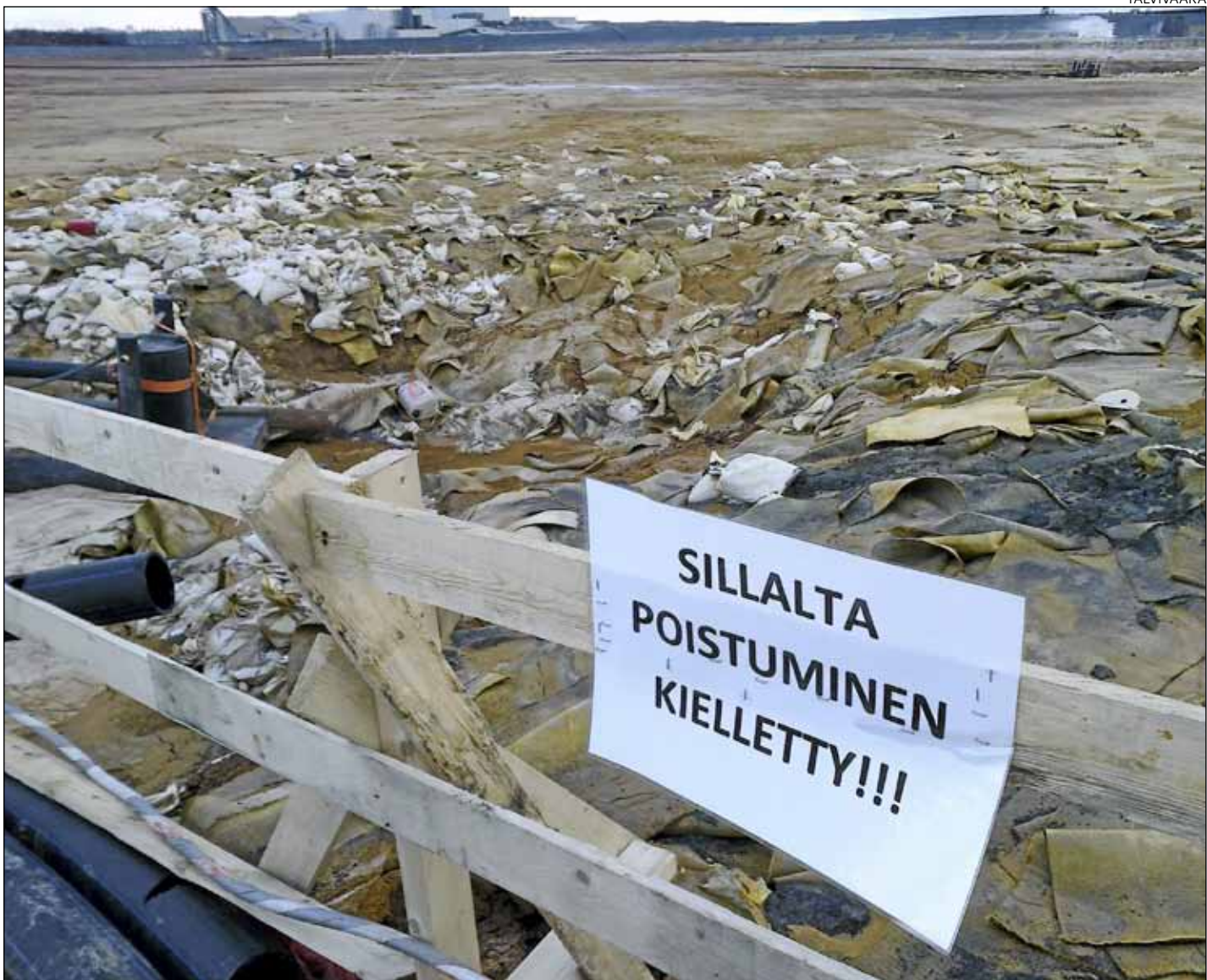
Talvivaaran kipsisakka-altaasta tukittiin kolme vuotokraateria. Nyt tuotantoa käynnistellään uudelleen.
