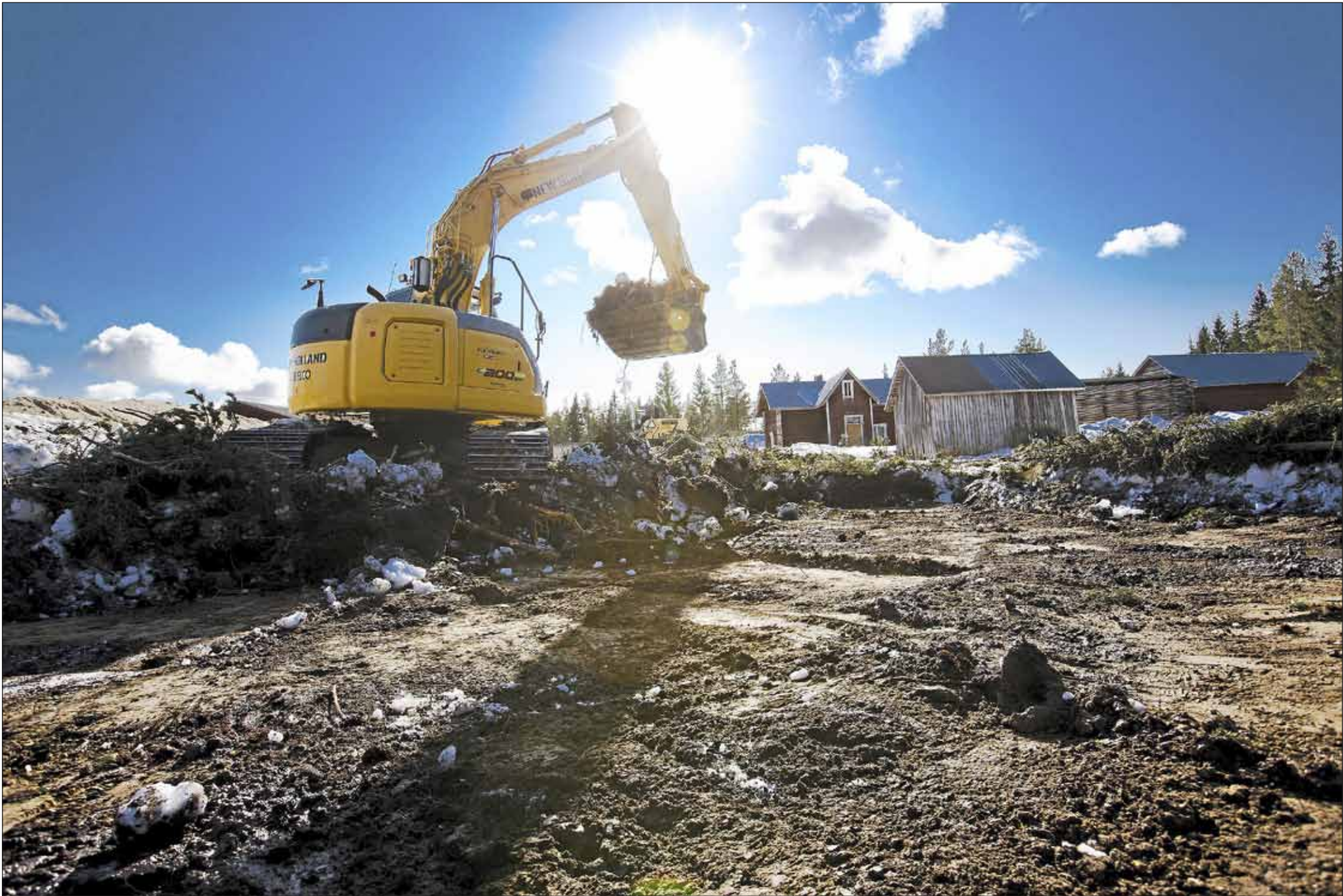
Navetta rakenteilla. Poistot kannattaa kohdistaa ensin rakennuksiin, vasta sitten koneisiin.
