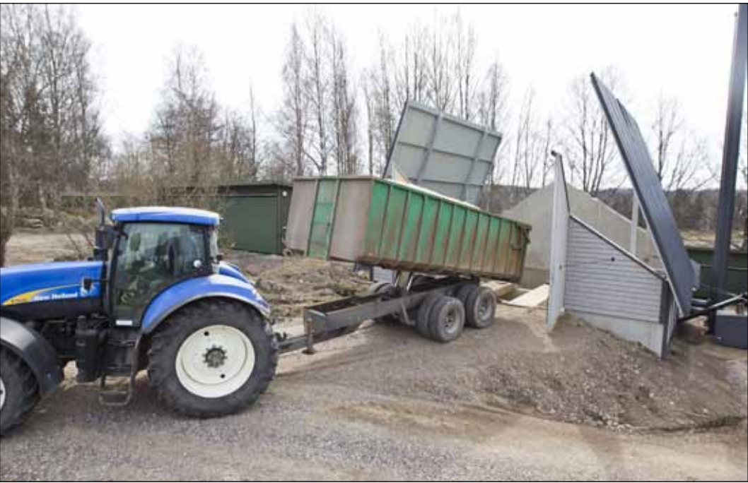
Hakelaitoksen avettava katto mahdollistaa hakekuorman kaatamisen suoraan yläkerran hakevarastoon.
