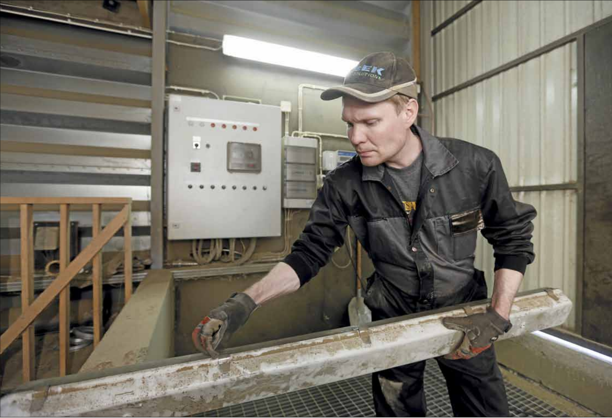
Mikko Heikkinen joutui vaihtamaan kuivaamon valaisimia. Vanhat eivät soveltuneet palovaarallisiin tiloihin.
