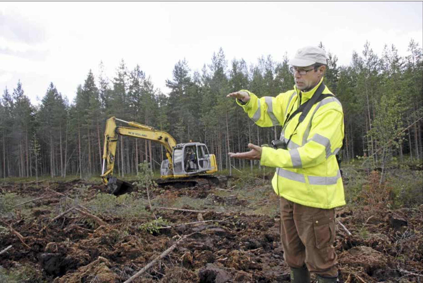
”Vesi nousee suolle, kun kaivinkone täyttää umpeen nevaa halkovan ojat”, projektipäällikkö Juha Siekkinen havainnollistaa.
