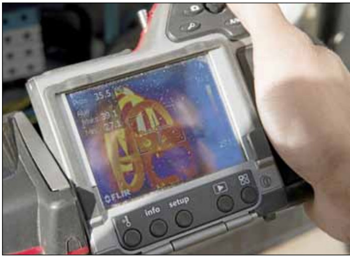
Lämpökamerasta on tullut sähkö tarkastajille tärkeä työkalu. Sillä pystytään löytämään sähkökytkennöistä asennusvirheitä ja löysiä liitoksia.
