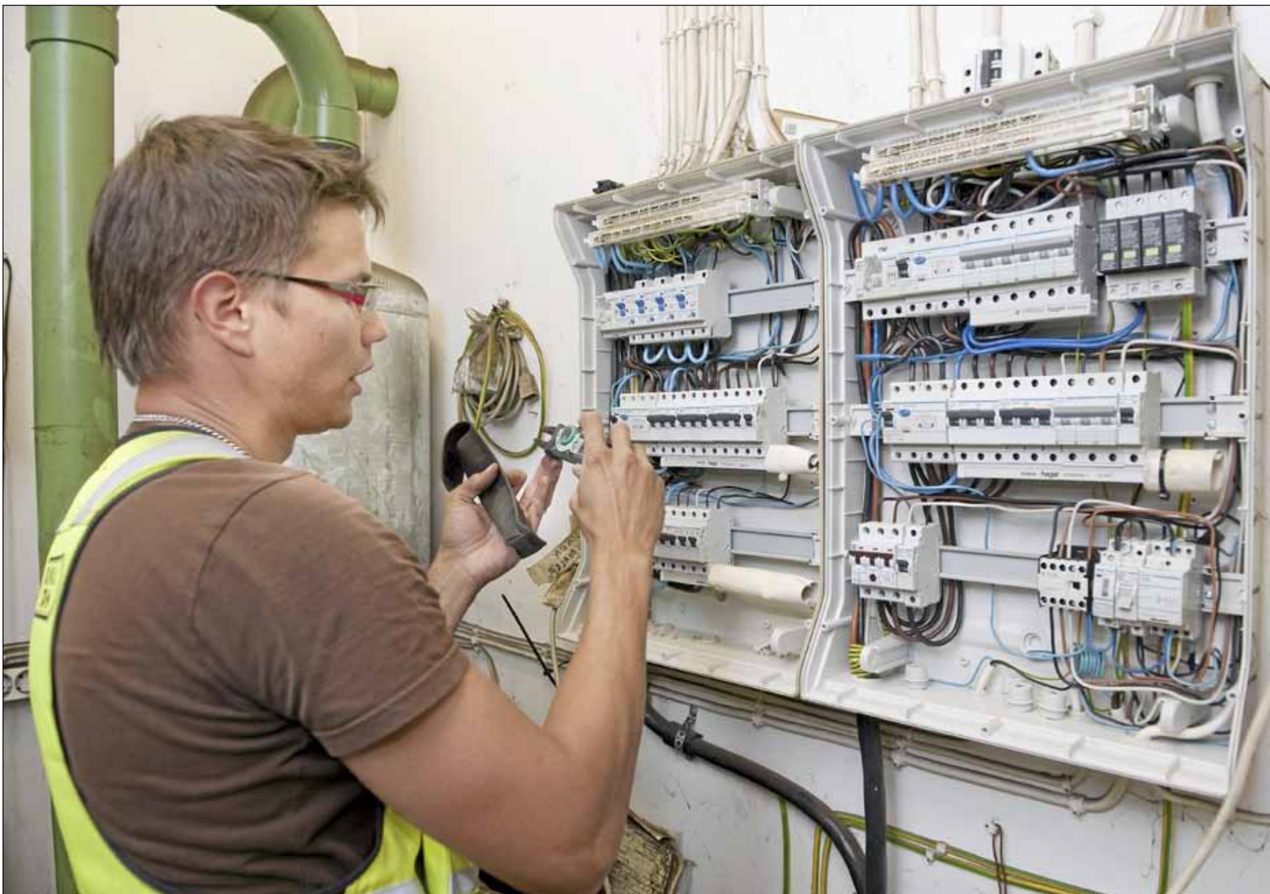
Veijo Malinen kuopiolaisesta Paikallissähköstä tarkasti sähköasennusten kunnon kotkalaisen Matti Hippolan tililla maanantaina.
