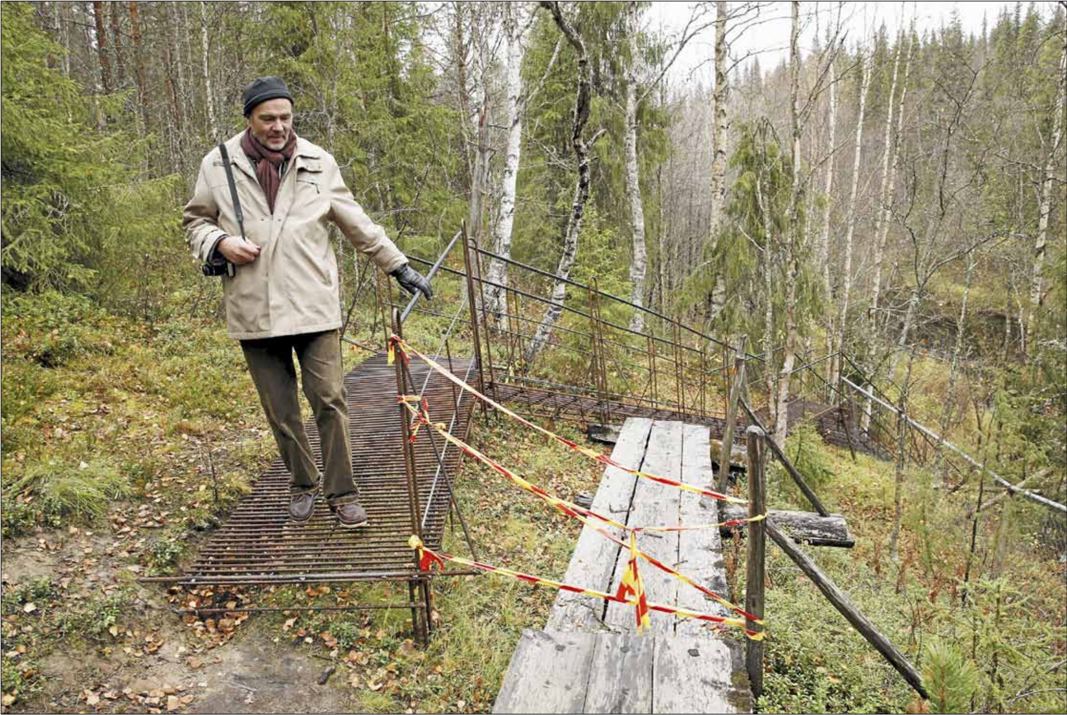
Suunnittelija Sulo Norberg sanoo teräksen olevan hyvä materiaali pitkospuissa. Auttikönkään vanhat puurakenteet ovat jo lahoja.
