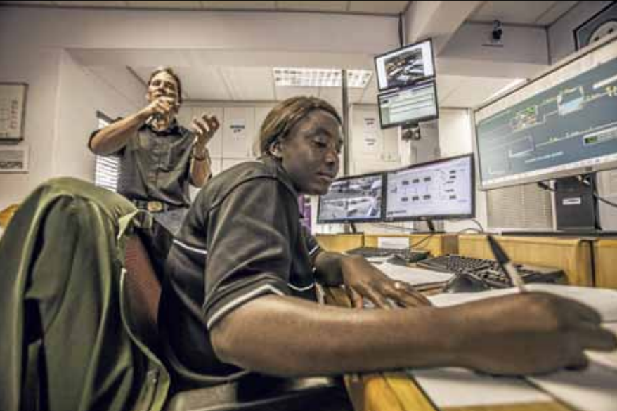
Dietlinde Andjene valvoo vedenpuhdistuksen kaikkia vaiheita. "Koko toiminta on periaatteessa hänen käsissään", toteaa Siegfried Mueller.
