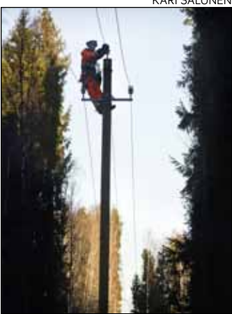
Etelän Jaakko Hiltunen korjasi sähkölinjaa perjantaina Kirkkonummella.
