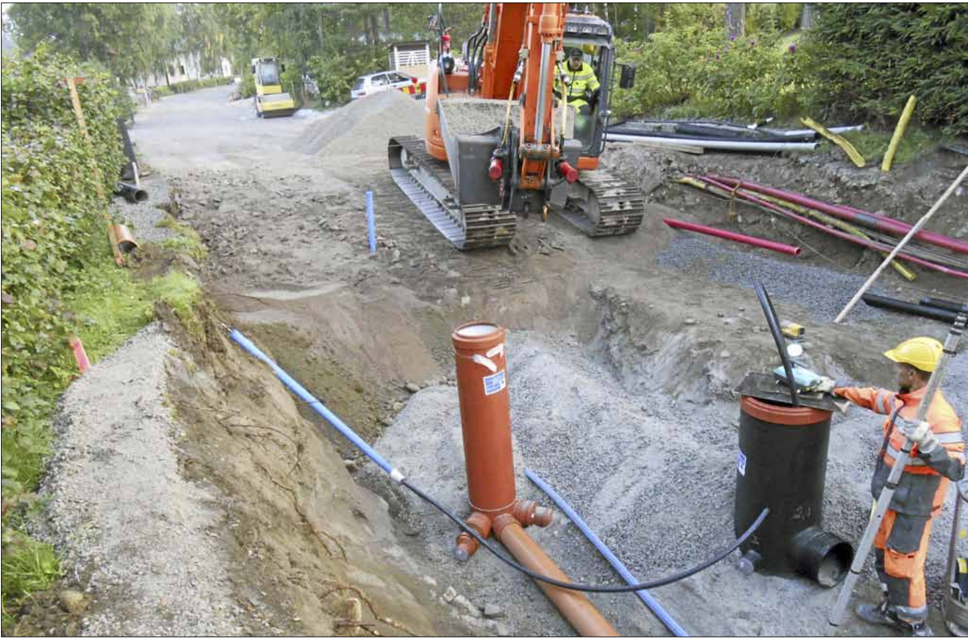
Vesi- ja viemäriverkostoja voidaan kunnostaa nykyisin myös niin, ettei koko linjaa tarvitse avata ja korvata. Kuvassa saneerataan verkostoa Hämeenlinnassa.
