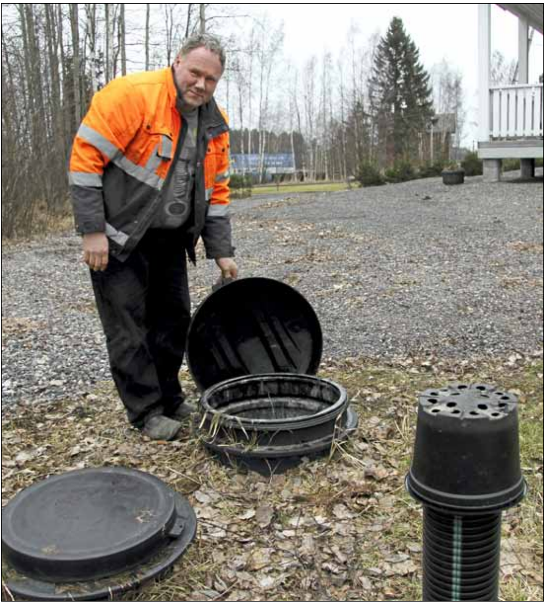
Maasuodatin on toiminut ongelmitta, Raimo Rantala sanoo. Suodatinkenttä on 13,5 metriä pitkä ja kolme metriä leveä.
