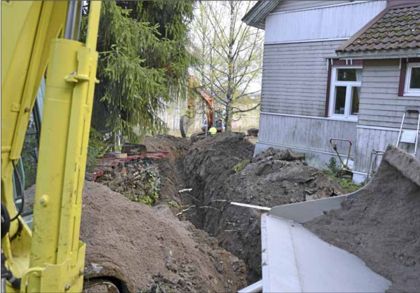
Jätevesiremontit etenevät hitaasti. Kuvassa tehdään kaivuutöitä viemäriosuuskuntaan liittyvän talon pihalla.
