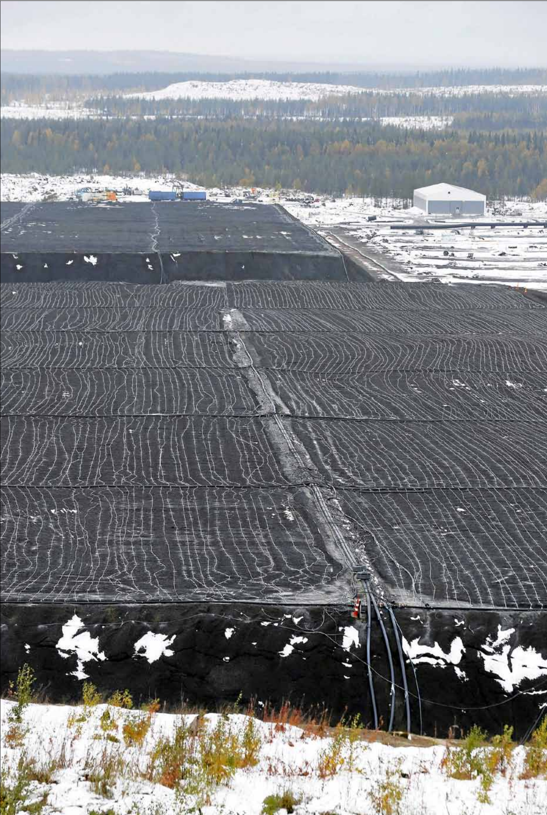
Talvivaaran kaivoksen neljästä bioliotuskasasta kaksi toimii kunnolla, muissa kasoissa on liikaa vettä. Vettyneitä kasoja yritetään elvyttää käyttökelpoisiksi. Kasojen pinnassa näkyy valkoinen putkisto, josta tihtuu liuotusnestettä malmimurskaeseen. Nesteessä on bakteereja, ne luottavat metallit malmista.
