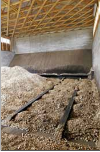
Sotkamon kantokone tuo Parkinniemeen haketta 44 kuutiometrin erissä. Kuusi tankopurkainta syöttää haketta kattilaan. Lämpökeskuksen on toimittanut kotimainen Biofire Oy. Puutarhuri Jyrki Tervosen mukaan järjestelmä on toiminut muutamaa häiriötä lukuun ottamatta hyvin. Jos tulipalo syttyy, sen eteneminen estetään syöttöruuvissa olevalla varasammutusjärjestelmällä.
