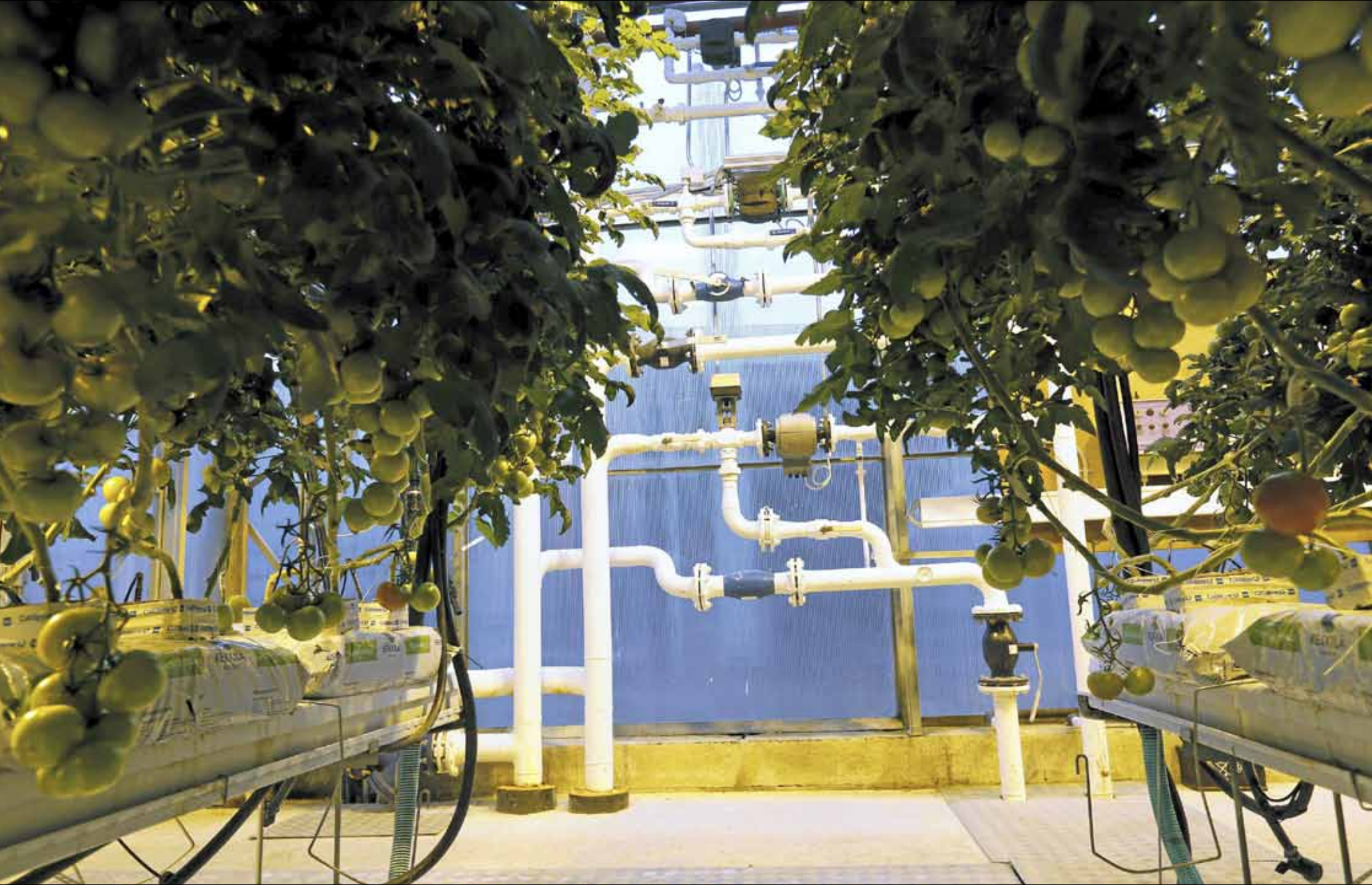
Parkinniemen puutarha Kajaanisssa vaihtoi lämmitysenergian öljystä puuhakkeeseen. Lämpö tulee kasvihuoneeseen teräsputkissa, joissa kulkee lämmin vesi. Paluuveden lämpötila määrää, millä teholla kattila käy. Järjestelmään kuuluu kaksi 80 kuutiometrin lämminvesivaraajaa.
