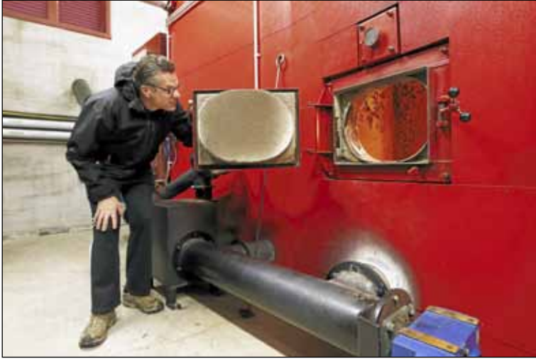
Sotkamon kantokone tuo Parkinniemeen haketta 44 kuutiometrin erissä. Kuusi tankopurkainta syöttää haketta kattilaan. Lämpökeskuksen on toimittanut kotimainen Biofire Oy. Puutarhuri Jyrki Tervosen mukaan järjestelmä on toiminut muutamaa häiriötä lukuun ottamatta hyvin. Jos tulipalo syttyy, sen eteneminen estetään syöttöruuvissa olevalla varasammutusjärjestelmällä.
