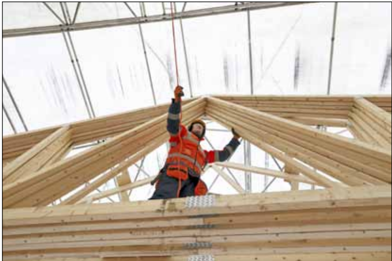
Oulussa omakotitaloja rakennetaan kiivaasti. Opiskelija Arttu Lampela asensi viime viikolla kattotuoleja Oulun Hiukkavaarassa.
