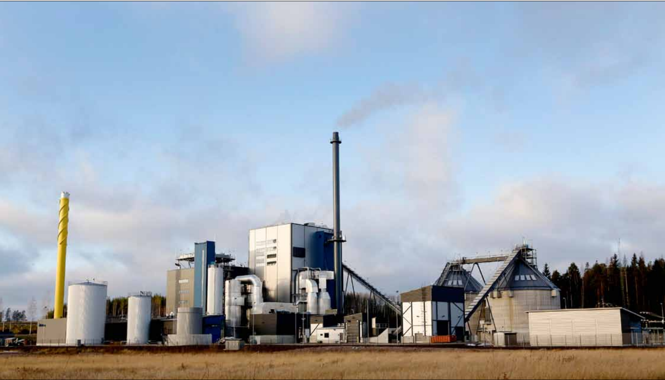
Fortumin Järvenpään voimalaitos polttaa metsähaketta, purua ja kuorta sekä kierrätyspuuta purkukohteista. Viime vuonna valmistunut laitos korvaa maakaasua ja raskasta polttoöljyä käyttäviä laitoksia.
