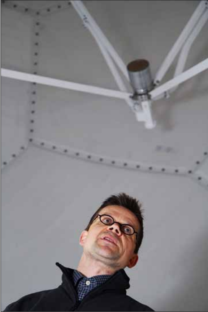
Tutkija Mikko Kurri antennisyötön alla tornin huipulla. Suojakuvussa ei ole pystysaumojia, koska ne voisivat häiritä mittauksia.
