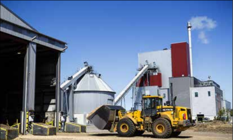
Puu ja turve palavat Keravan Energian biovoimalaitoksella. Sivu 10
