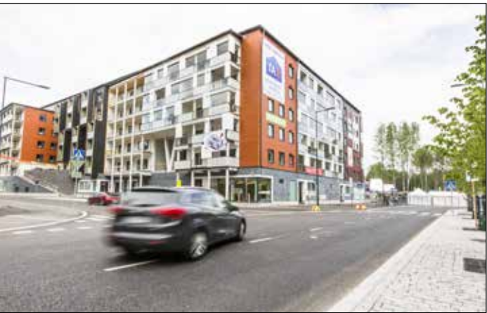
Euroopan suurimmassa puukerrostalossa puuta näkyy lähinnä v-kirjaimen muotoisissa kantavissa rakenteissa.
