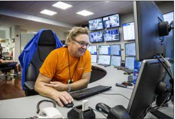
Hannu Karhu valvoo, että polttoaine kulkee ja palaa ongelmitta Salmisaaressa. Hienoksi jauhettu hiili- ja pellettipöly palaa kattilassa 3-4 sekunnissa.
