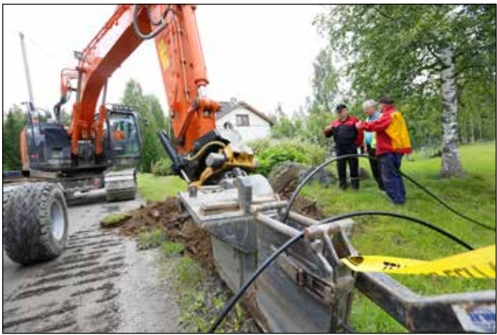
Kiinteiden valokuituverkkoyhteyksien vetäminen on käynnistynyt Kannonkoskella.
