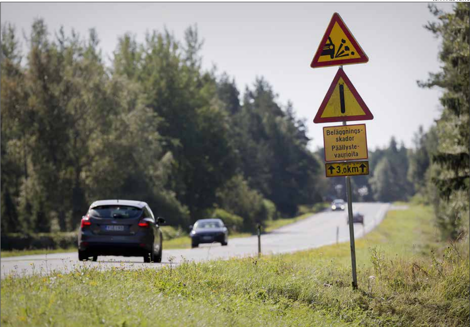
Tässä jyrisivät vasta pari kuukautta sitten asfalttikoneet. Nyt liikennemerkit varoittavat taas vaurioituneesta päällysteestä.
