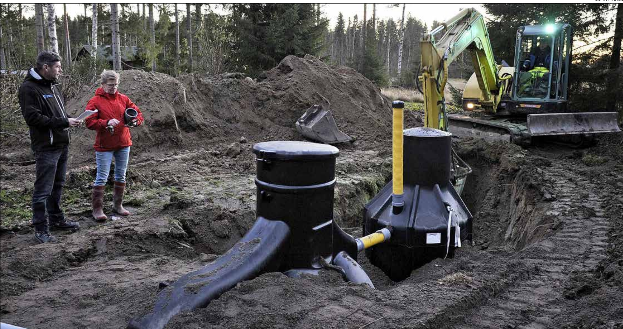
Irmeli Haapaharjun omakotitaloon Lapualla asennettiin jätevesijärjestelmää keskiviikkona. Kaivuuhommissa on Jari Kangas ja vastaavana mestarina Ari Peltola.
