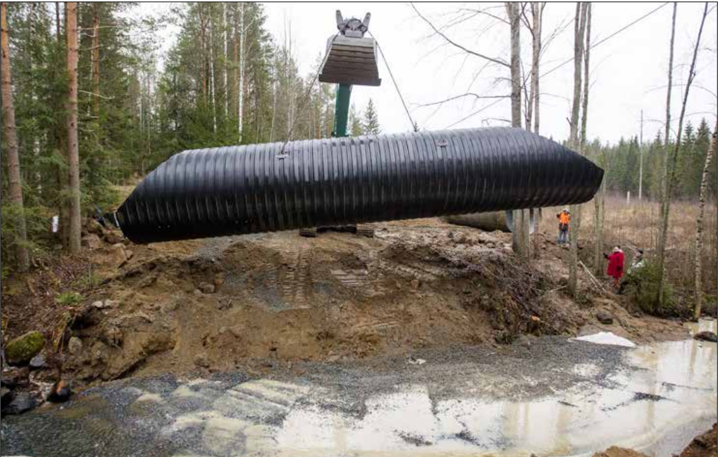
13 metriä pitkä ja 2,4 metriä halkaisijaltaan oleva 2 500 kilon muovitettu teräsputkisilta laskeutuu nättisti paikalleen Kuokkakoskeen Heinolassa. Sillan käyttöäikäksi lasketaan 91 vuotta.
