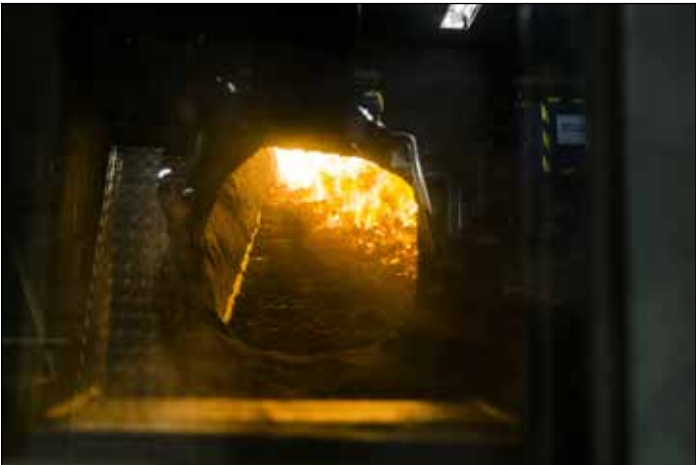
Ohran kuori palaa Altian vuosi sitten käyttöön ottamassa biokattilassa, jolla tuotetaan tislauksessa tarvittava höyry.
